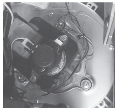
**Sonda temperatura fumi:** questa termocoppia rileva la temperatura dei fumi mantenendo il funzionamento oppure arrestando la stufa quando la temperatura dei fumi scende sotto il valore preimpostato.
